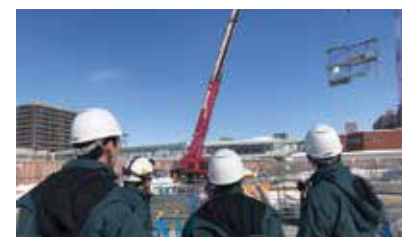
1DAYインターンシップ／工事業所を見学
