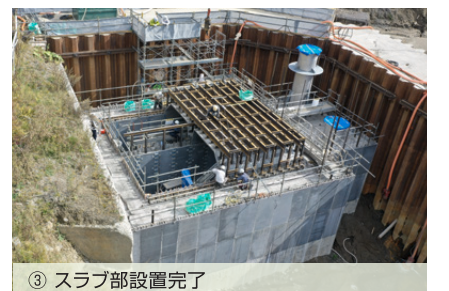
③ スラブ部設置完了
