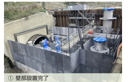
① 壁部設置完了
