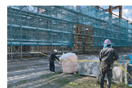
▲ 作業所での災害訓練
