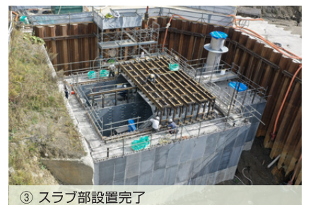
③ スラブ部設置完了
