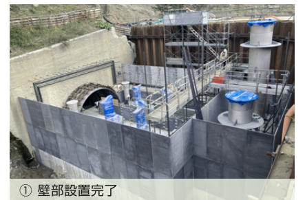
① 壁部設置完了
