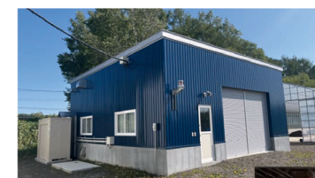
◀ パイロットプラント外観
