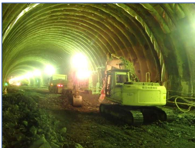
インバート掘削
