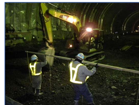
掘削高さ管理
