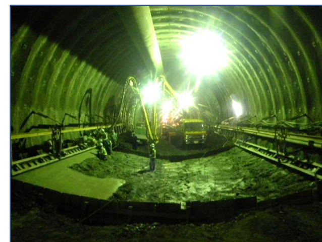
コンクリート打設
